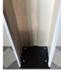
■ Ayak-Zemin Bağlantı Detayı Foot-Ground Connection Detail
